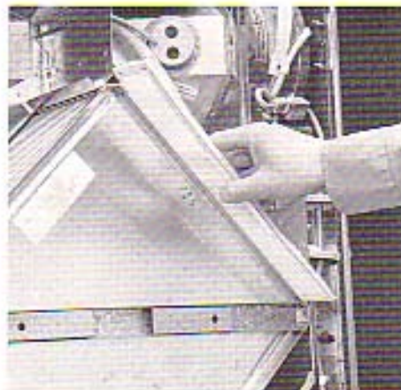
Ta bort filtret genom att dra det rakt ut. Ramen ska vara nedåt när filtret sätts tillbaka.
